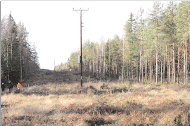
Strängnäs energis ledningsgata Häradslinjen. Botten röjd och behandlad med ECOPLUG för åtta år sedan och därefter breddad och behandlad med ECOPLUG för tre år sedan. I övrigt har ingen röjning gjorts.
